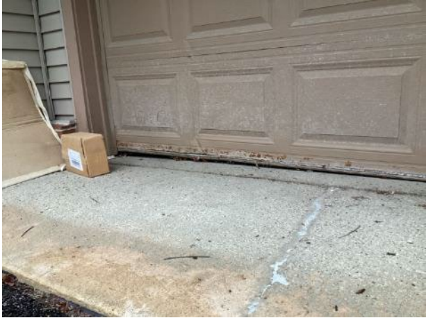
Garage door displacement
